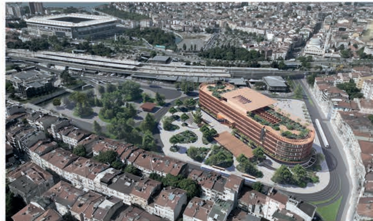
Kadıköy Belediye Binası Kentsel Bağlamı / Kent Parkı ve Demokrasi Meydanı Arasında bir "Eşik"
